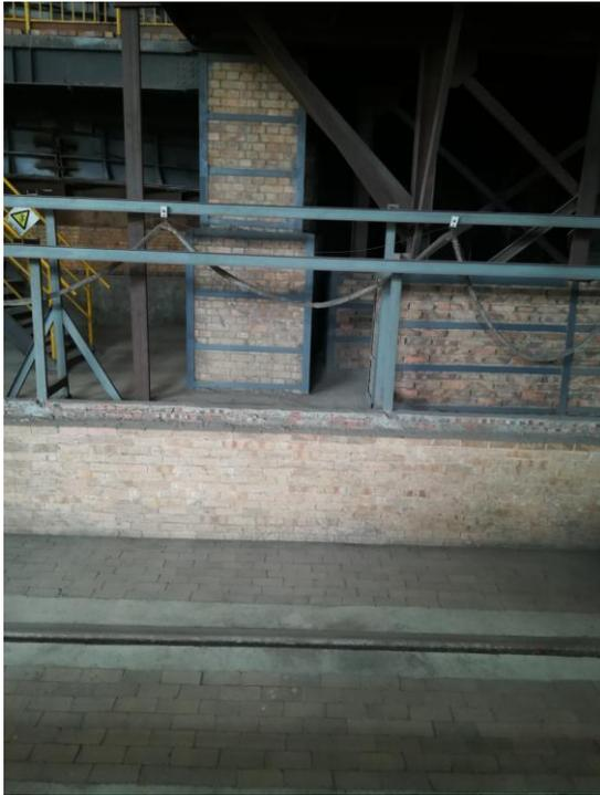
耐火材料砌成的防火墙
