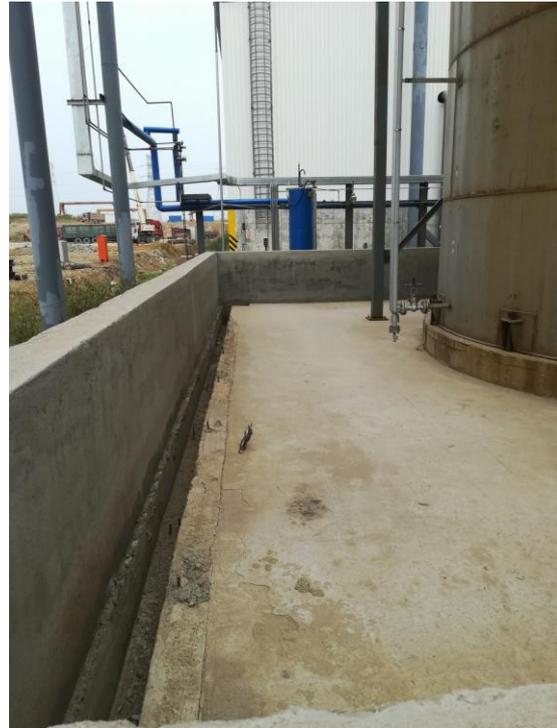
二期项目氨水罐区围堰和导流沟
