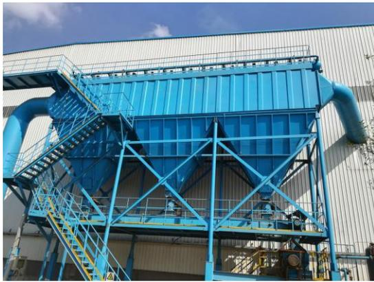
离线破碎废气处理设施布袋除尘器
